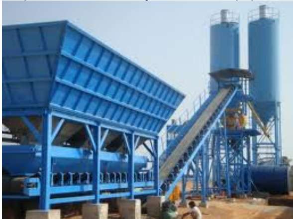
Trạm trộn Bê tông
